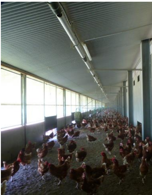
Abb. 3: Verlauf von Förderrohren oberhalb des Scharbereiches im Kaltscharrraum von zwei Projektställen
