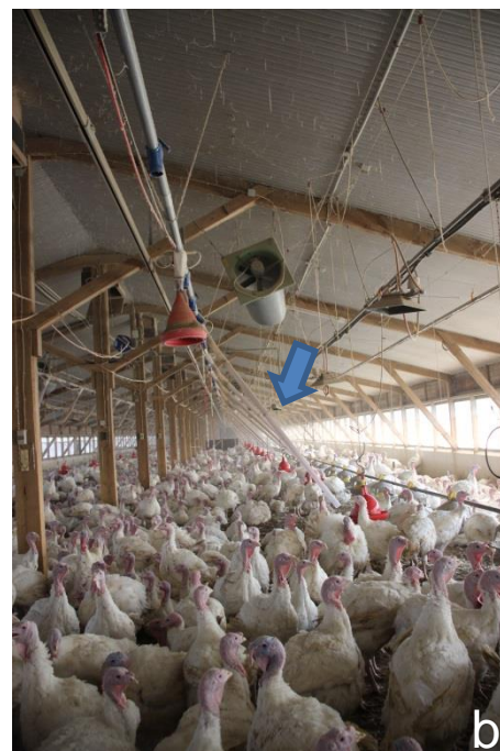
Abb. 78: Rohrfördersystem mit kurzen Rohren an den Dosierventilen im linken Teil des Stalls (a) und langen Rohren an den Dosierventilen im rechten Teil des Stalls (b)
