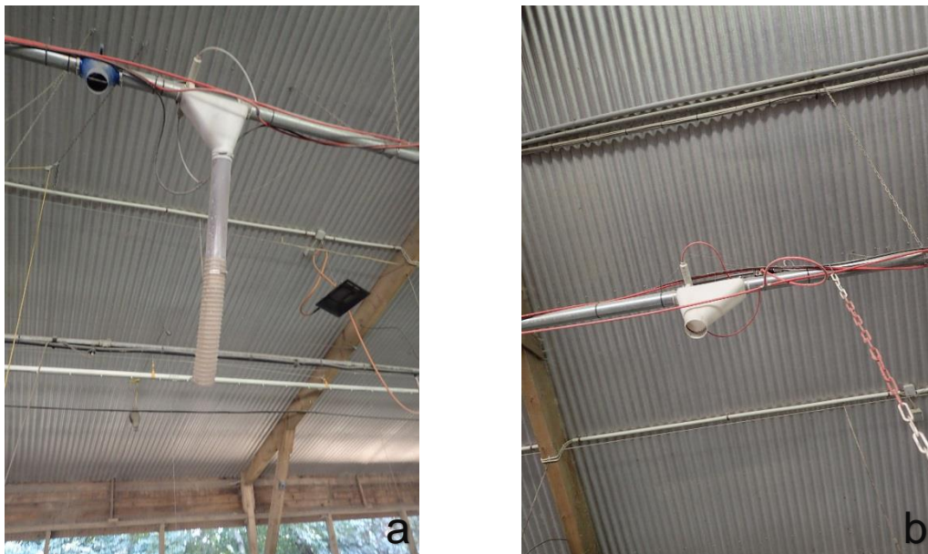
Abb. 82: Unterschiedliche Dosierventile zum Einbringen der Einstreu: Dosierventil mit Rohr zum synchronen Nachstreuen (a) und Dosierventil zum manuellen sektionalen Einstreuen (b)
