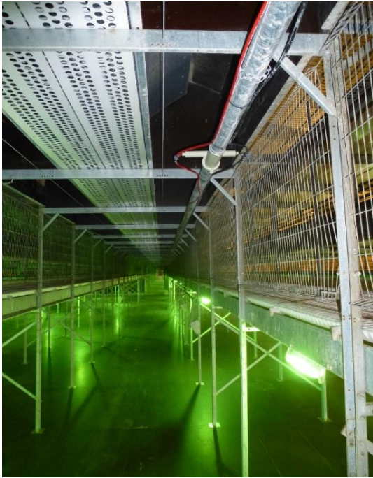
Abb. 2: Verlauf von Förderrohren oberhalb des Scharbereiches im Stallinnenraum von zwei Projektställen
